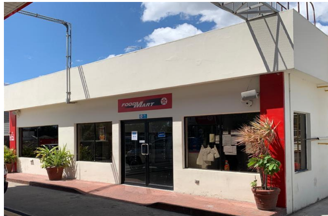
Ilustración 12. Exterior de tienda de conveniencia Foodmart.
