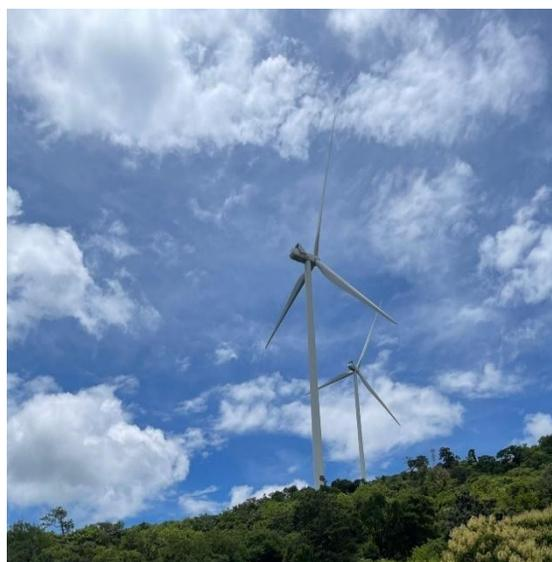
Nota. El parque eólico VENTUS cuenta con 15 aerogeneradores con una altura de 120 mts, estos están destinados a generar una potencia de energía de 54 mw. Elaboración propia.
